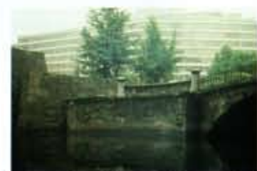
写真1 築城時に創設された常盤橋たもと石積み護岸
