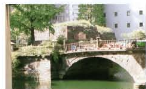
写真4 常盤橋の全景
