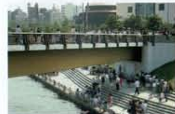
写真3 隅田川右岸に近年になってつられた親水テラス
