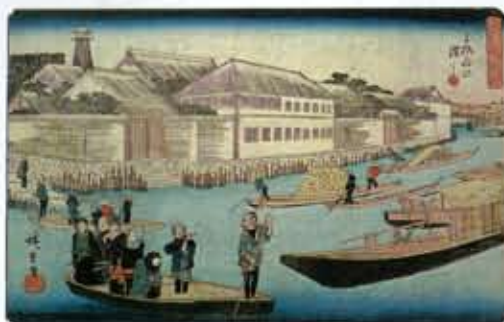
図18 「鐘の渡」日本橋川(広重画)。水辺に石積みの表現がある
